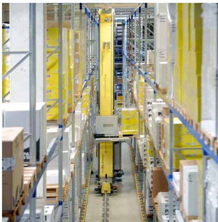
Papstar, statyczne przechowywanie palet na wyższych poziomach, gdy na najniższym poziomie palety są składowane w kanałach przepływowych, aby były dostępne w strefie kompletowania zamówień
