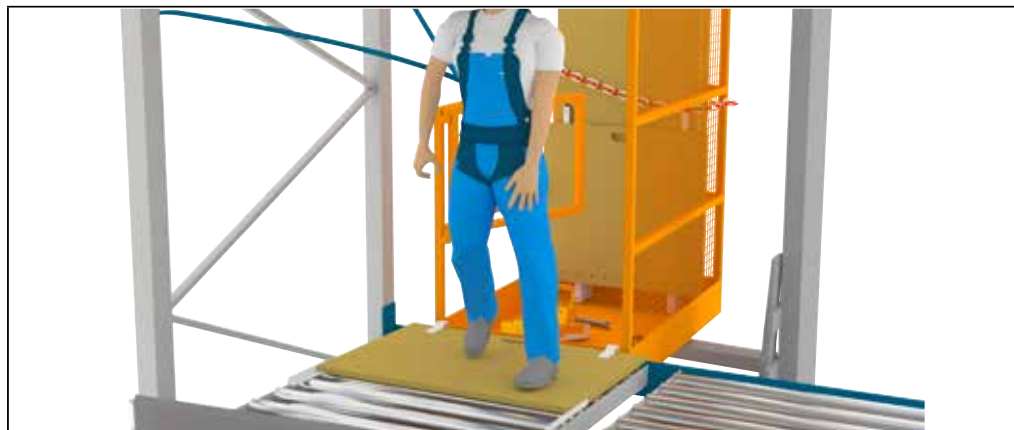
Abbildung 28: Austritt aus der Arbeitsbühne auf das Startbrett zur Begehrbarkeit
