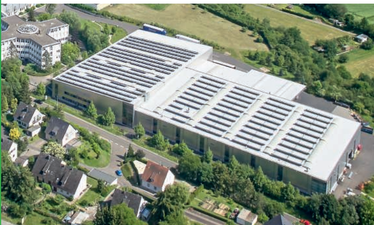
BITO Meisenheim – Photovoltaikanlage
